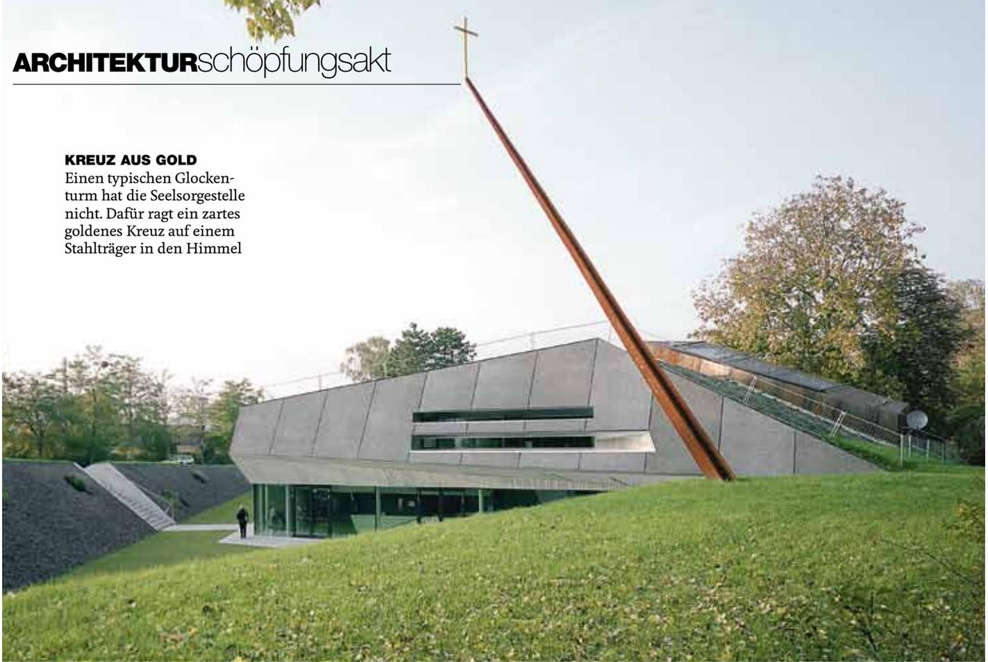
worden. Die Kirche sollte nicht auf kontaminiertem Grund stehen: Sie liegt zweieinhalb Meter unter Straßenniveau und schält sich wie eine Höhenschichtlinie organisch aus der Landschaft. Der frei geformte Baukörper ist mit Betonfertigteilen verkleidet, denen Hochofenschlacke beigemischt wurde. Der Farbton passt sich den Schotterhügeln an.
